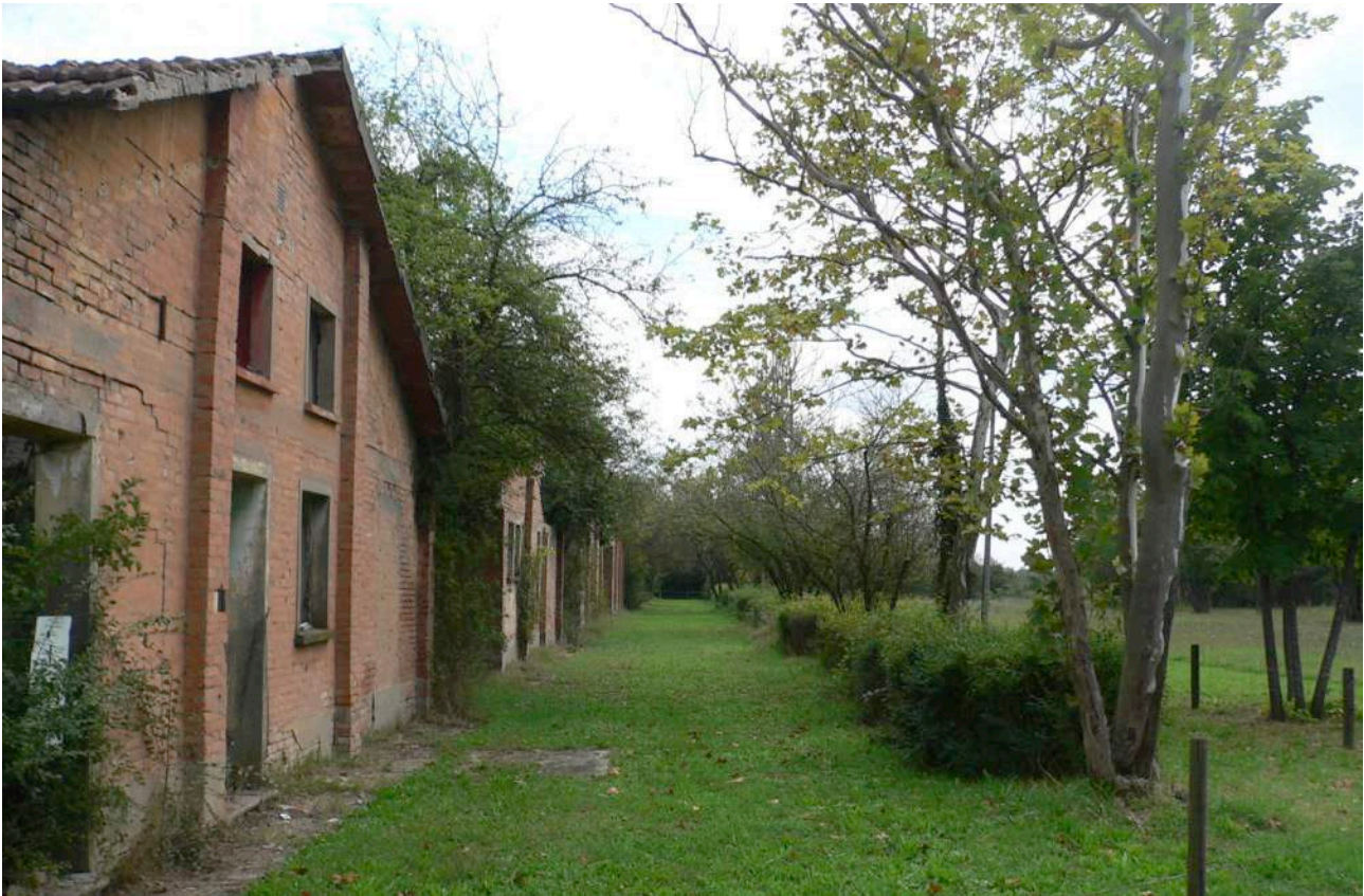
Figura 2-3 Il sistema di siepi miste ( Ligustrum sp. , Crataegus monogyna , Prunus sp. ) e filari di Prunus sp. che delimitano gli spazi adiacenti agli edifici n. 4.1 - 4.8
